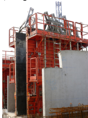
Les banches équipées de compas
