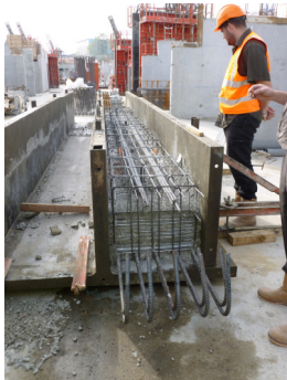
Fabrication des poutres
