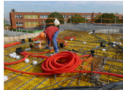
Un plancher avant coulage
