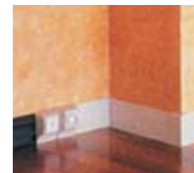
Installation en plinthe PVC
